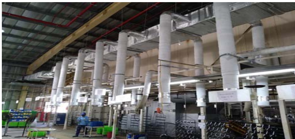
<スプリンクラーポンプ設備>
